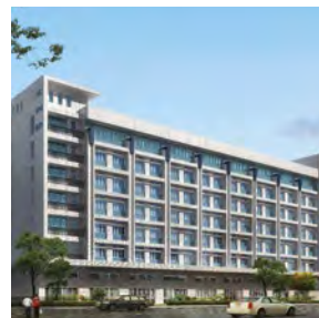
Niższe budynki wielkopowierzchniowe
